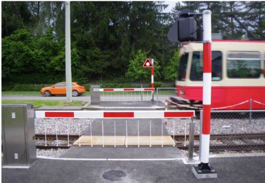
Bahnübergang Geeren der Forchbahn in Zollikerberg
